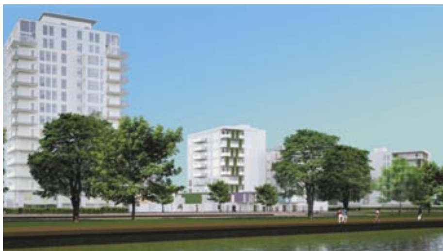
Bilden visar höghusen, hus 4 och hus 5
